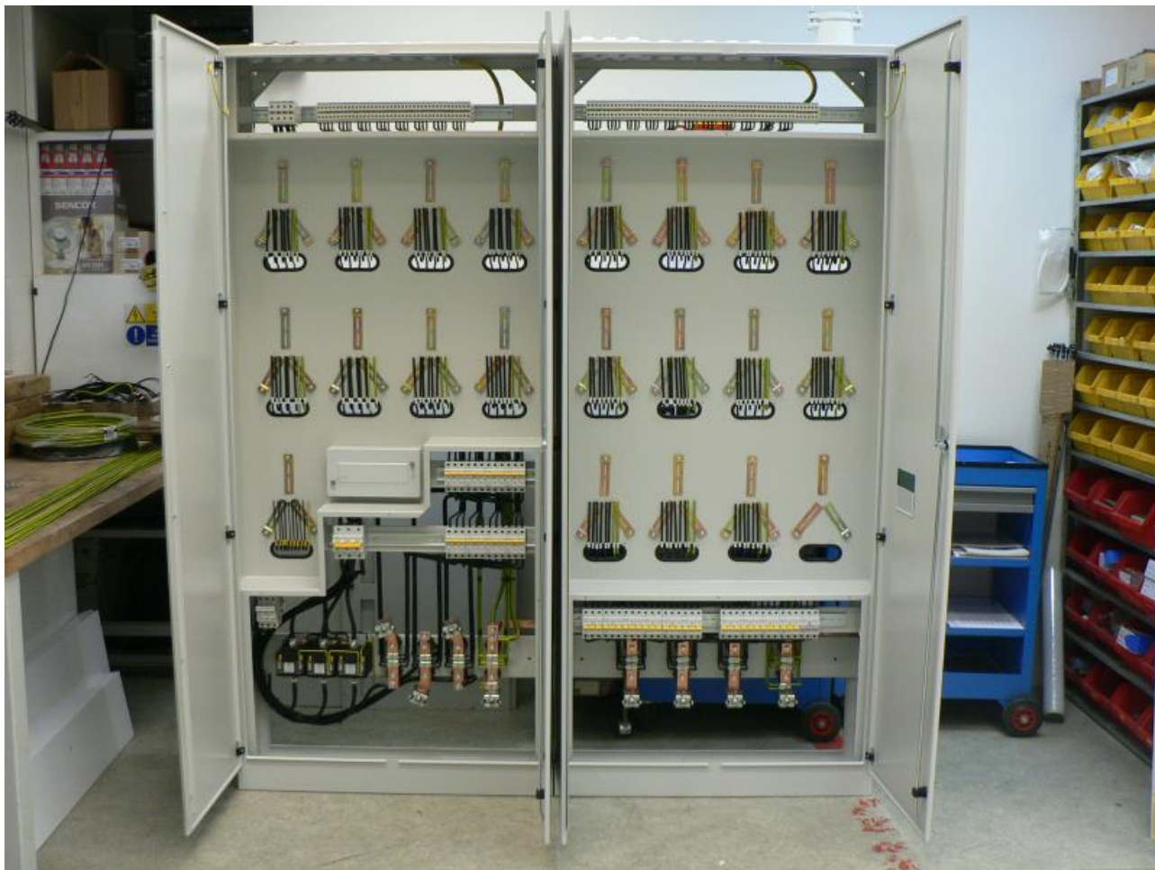
ES 7 kombinace přímého měření s nepřímým měřením
