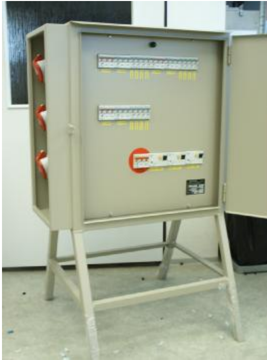
Staveništní rozvaděč s 18-ti zásuvkovými vývody.
