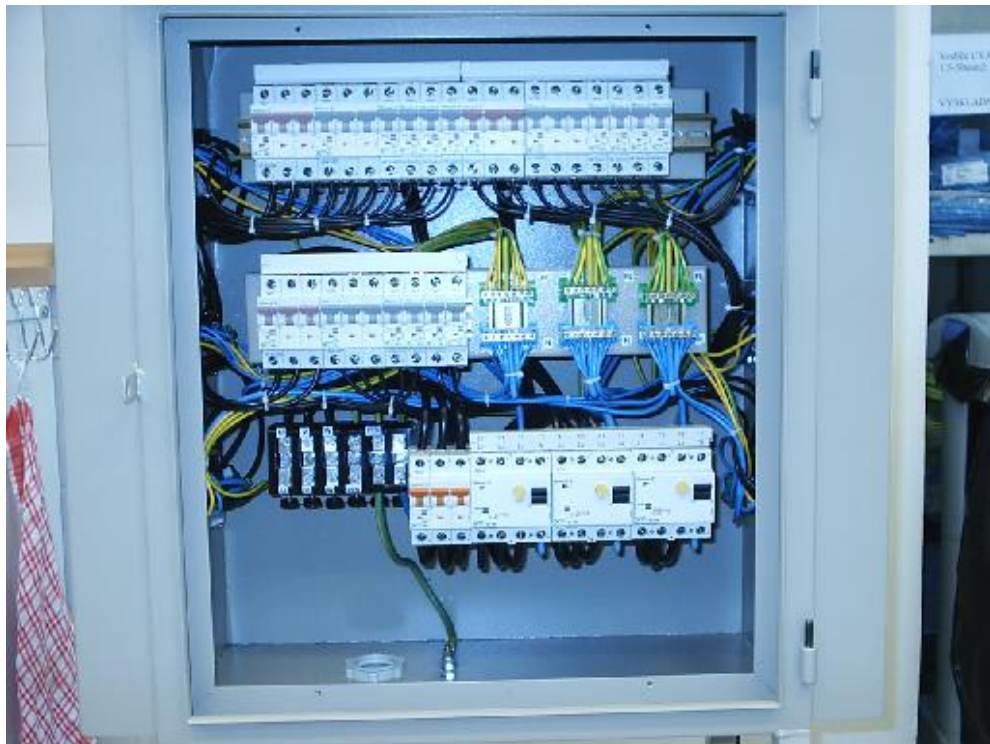
Staveništní rozvaděč s 18-ti zásuvkovými vývody.
