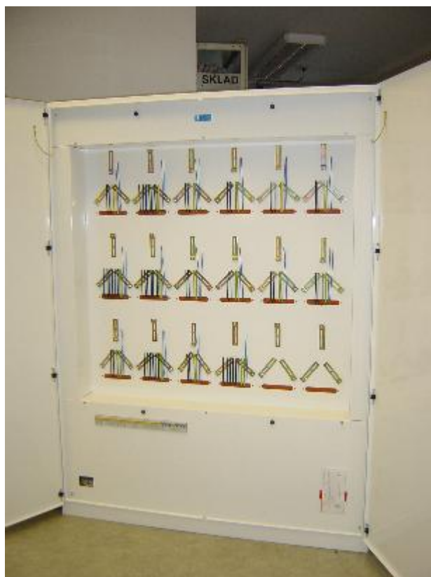
Rozvaděč pro 18 odběratelů určený pro instalaci na omítku
