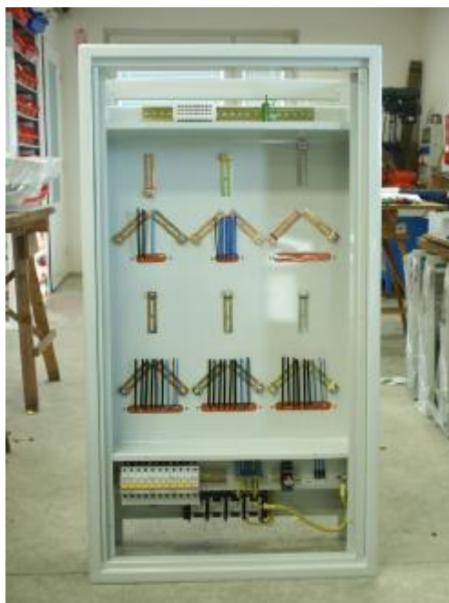
Skupinové zapojení dvousazbového měřicího zařízení s třípovelovým přijímačem HDO pro použití v ČEZ.
