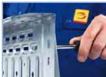
Přiložení děrovaného kabelového žlabu na výložník
