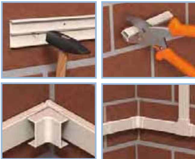
Dělicí nůžky OBO pro stříh bez otřepů až do velikosti kanálu 25 x 45 mm naleznete v OBO katalogu LFS.
