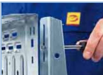
Přiložení děrovaného kabelového žlabu na výložník
