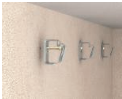
Nástěnná montáž svazkových držáků Současná montáž šroubových kotev nebo hmoždinek Angler a šroubu Sprint se svazkovým držákem průvlečným způsobem.
