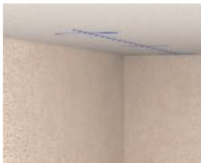
Příprava montáže Pro správné vrtání otvorů pro svazkové držáky použijte trasovací šňůru.
