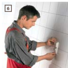
6 elektrické připojení regulátoru podlahového vytápění
