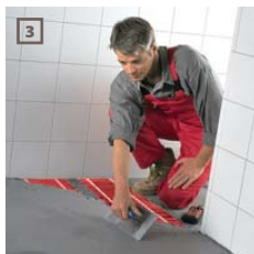
3 celoplošné nanášení lepidla pro dlaždice na výšku topného vodiče
