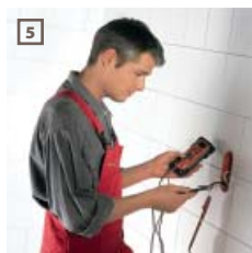
5 měření elektrického odporu topné rohože
