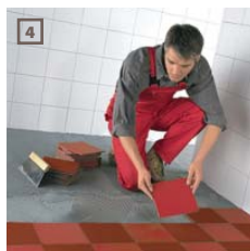
4 nanášení lepidla a pokládání dlaždic
