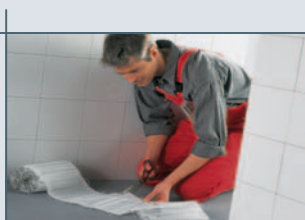
2. nastřihávání topné rohože pro přizpůsobení tvaru půdorysu místnosti
