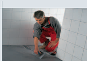
5. nanášení lepidla pro dlaždice a pokládání dlaždic. Pro dosažení nejlepší tepelné vodivosti, musí být lepidlo nanášeno celoplošně a bez vzduchových bublin.
